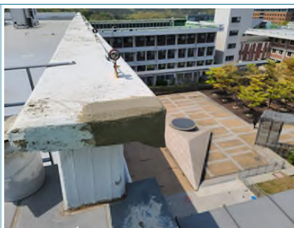
[콘크리트 단면 복구]
