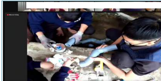
[실시간 온·오프라인 정수 나눔: 배관 보수]
