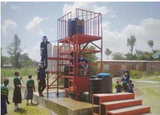
<필터, 저장탱크 설치, '17년 동계>
