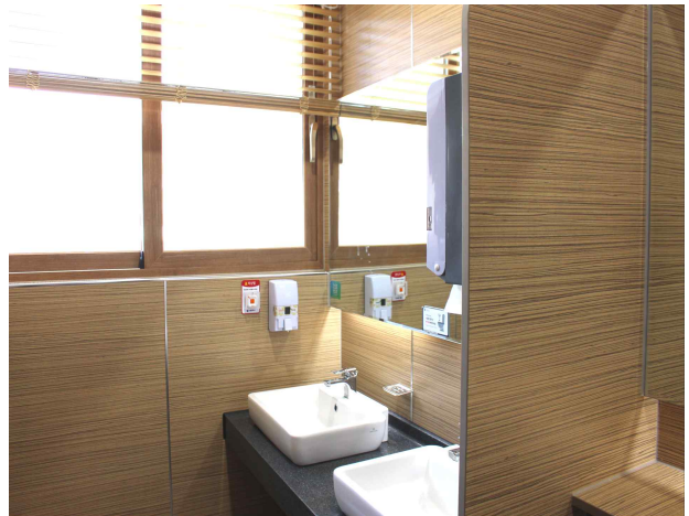
<보건진료소 화장실 개선>
