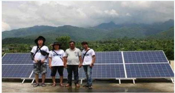
<Bhimshen School 태양광 발전시설 설치, '17년 하계>
